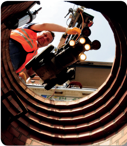
Überprüfungsarbeiten mit Hilfe eines Roboters
